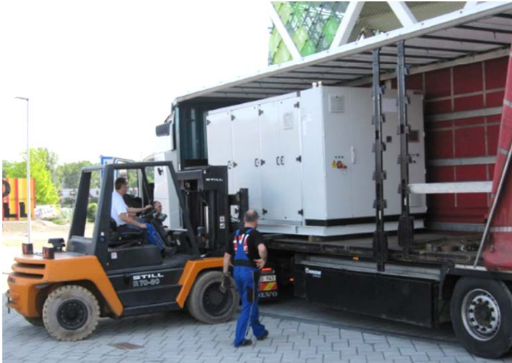
Bild 51 Lieferung der Wärmepumpen
