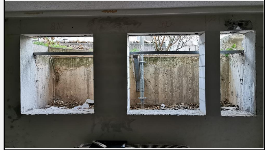
Trennung zwischen Zu- und Abluft der Wärmepumpe
