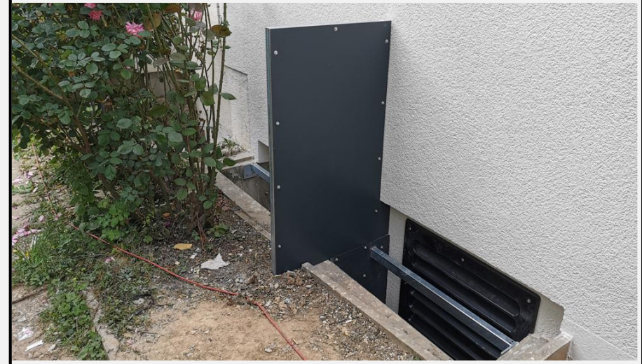
Trennung zwischen Zu- und Abluft der Wärmepumpe
