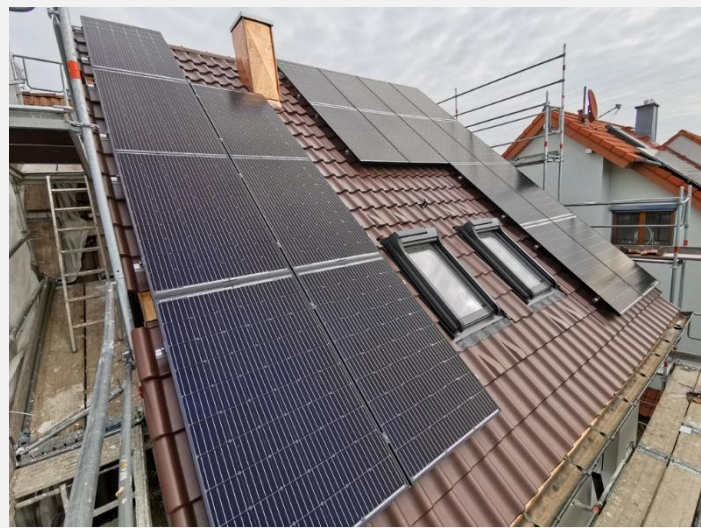
PV-Anlage: 19 Module nach Süden mit Moduloptimierer
