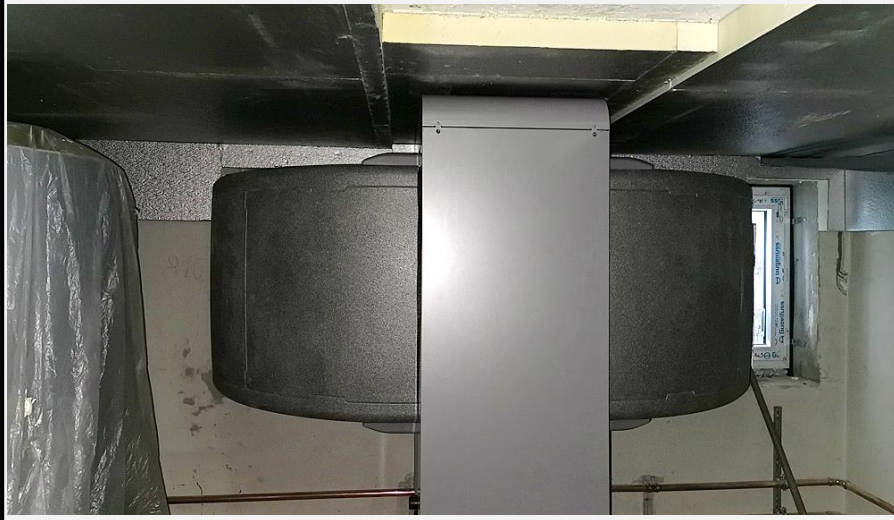
Wärmepumpe Inneneinheit mit Lüftungskanälen
