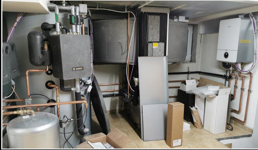
Wärmepumpe Inneneinheit mit Lüftungskanälen
