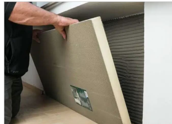
Dämmung Heizkörpernische
