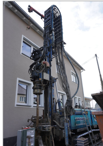
Erdsondenbohrungen
