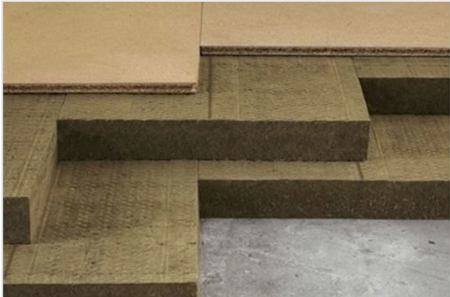
Dämmung oberste Decke
