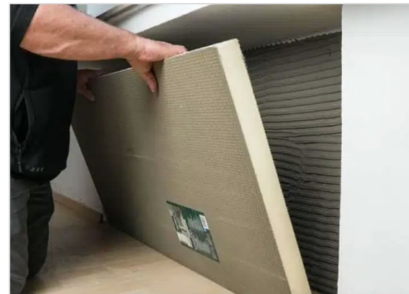
Dämmung Heizkörpernische
