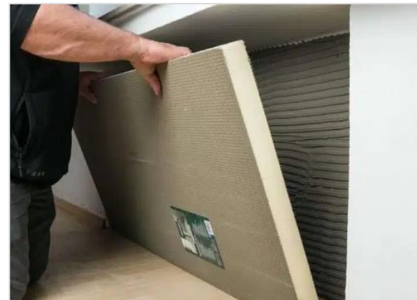
Dämmung Heizkörpernische
