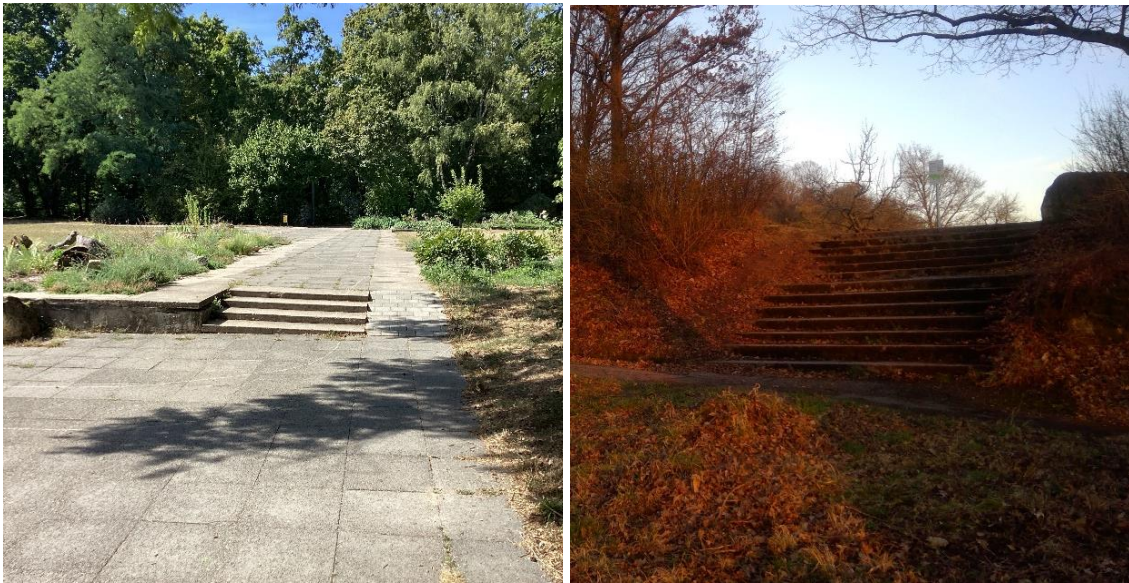
Abbildung 11: Treppenanlage ohne Geländer und Kontraste
