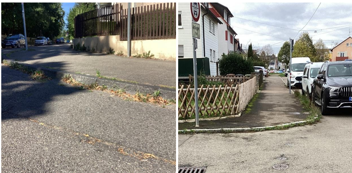
Abbildung 9: Nicht abgesenkte Bordsteine
