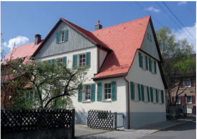
Durchgreifend modernisiert: Gebäude in Stuttgart-Vaihingen
