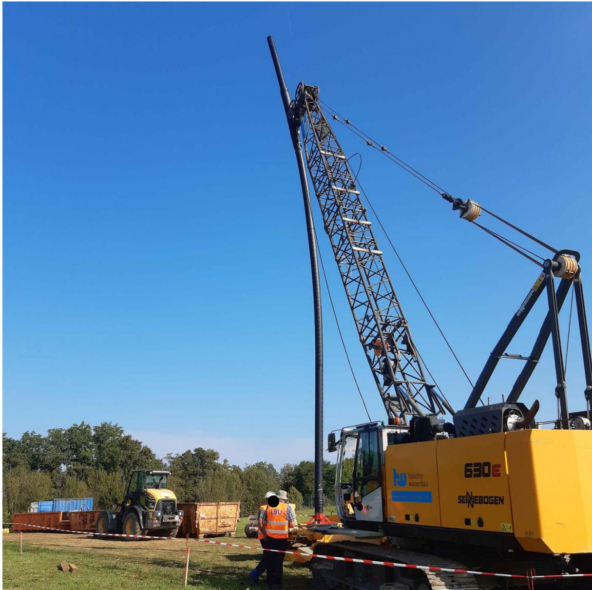
Einbringen des Brunnenrohres
