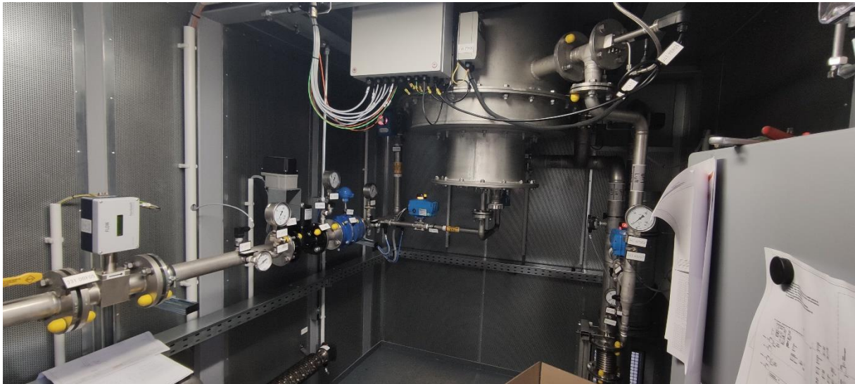
Maschinenraum der Schwachgasbehandlungsanlage, Sicht in Richtung Kamin
