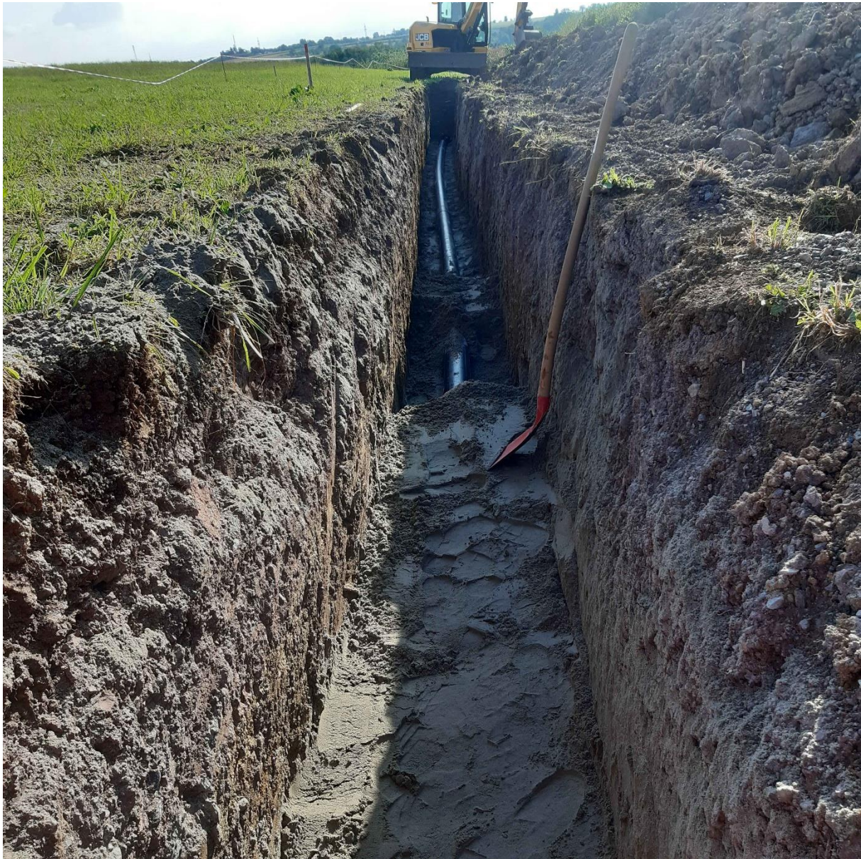
Abschnittsweiser Aushub Rohrgraben, Ausbildung Rohraufleger, Einlegen Transportleitung
