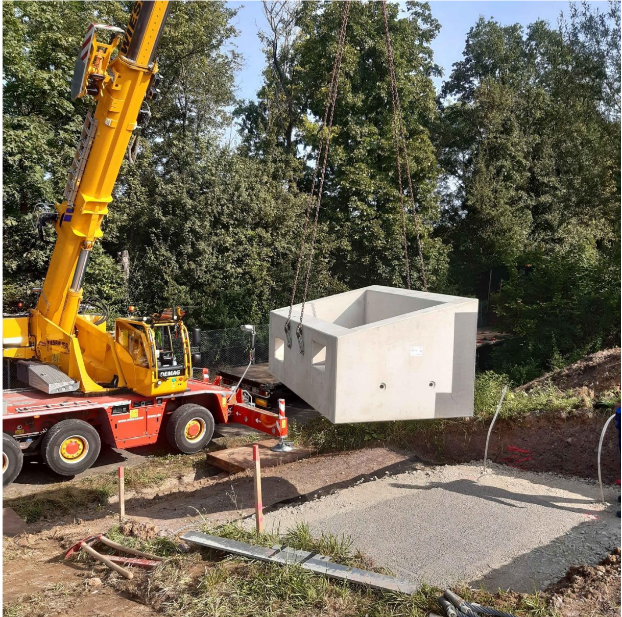
Anlieferung und Aufstellen der Gasregelstation
