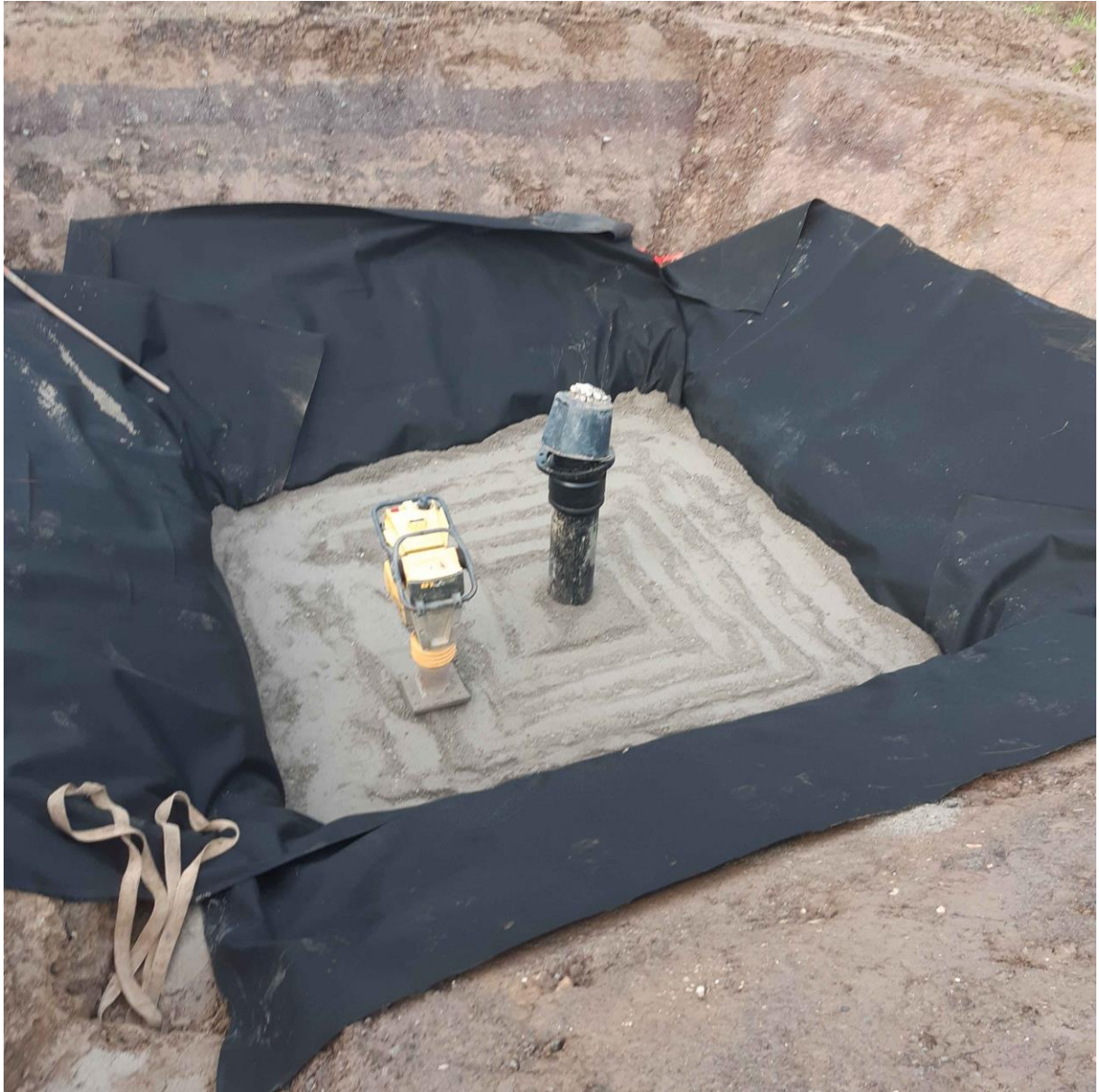
Schichtweises Verfüllen und Verdichten des Bohransatzpunktes
