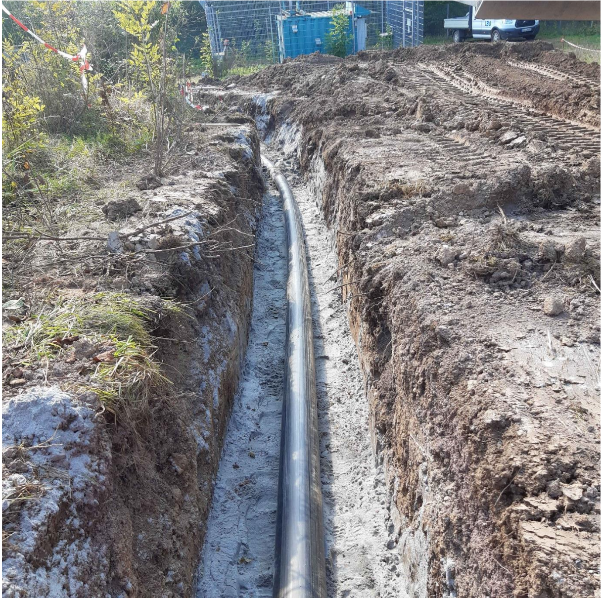
Einlegen der Transportleitung zum Standort der neuen Schwachgasbehandlungsanlage
