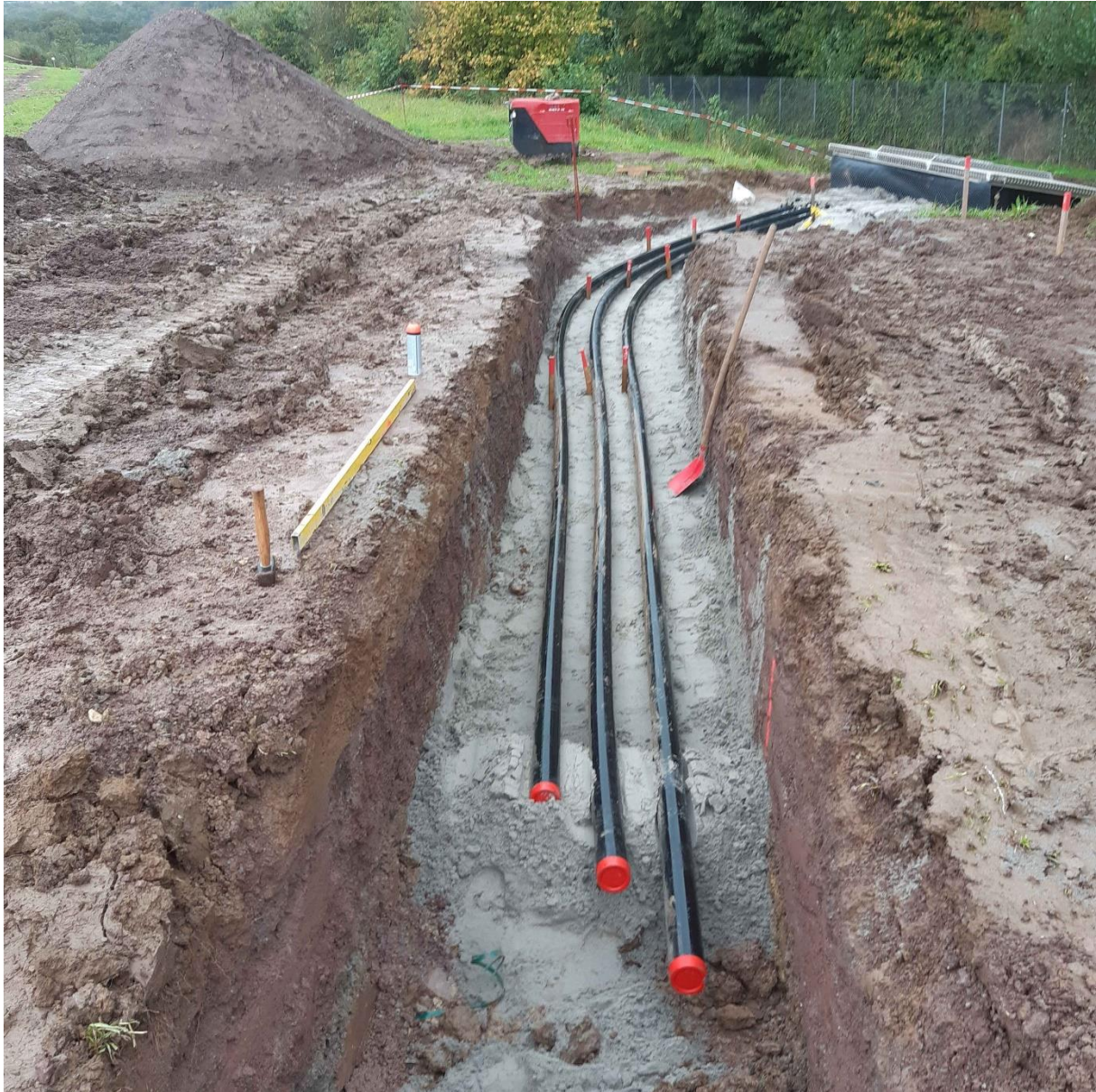
Rohrgraben mit parallel verlegten Sammelleitungen der Gasbrunnen zur Gasregelstation
