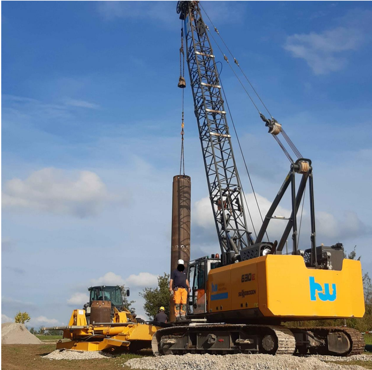
Bohrung für die Gasbrunnen mit paralleler Einbringung eines Schutzrohres
