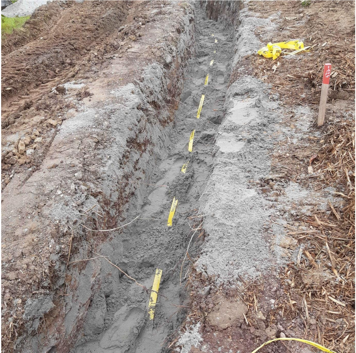
Wiederverfüllen des Rohrgrabens mit Sandschutzschicht und Trassenwarnband
