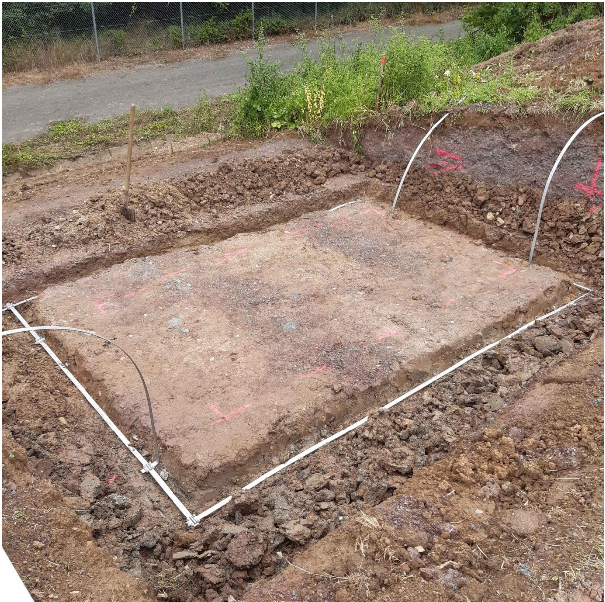
Aushub und vorbereitende Maßnahmen Erdungsanlage für Gasregelstation
