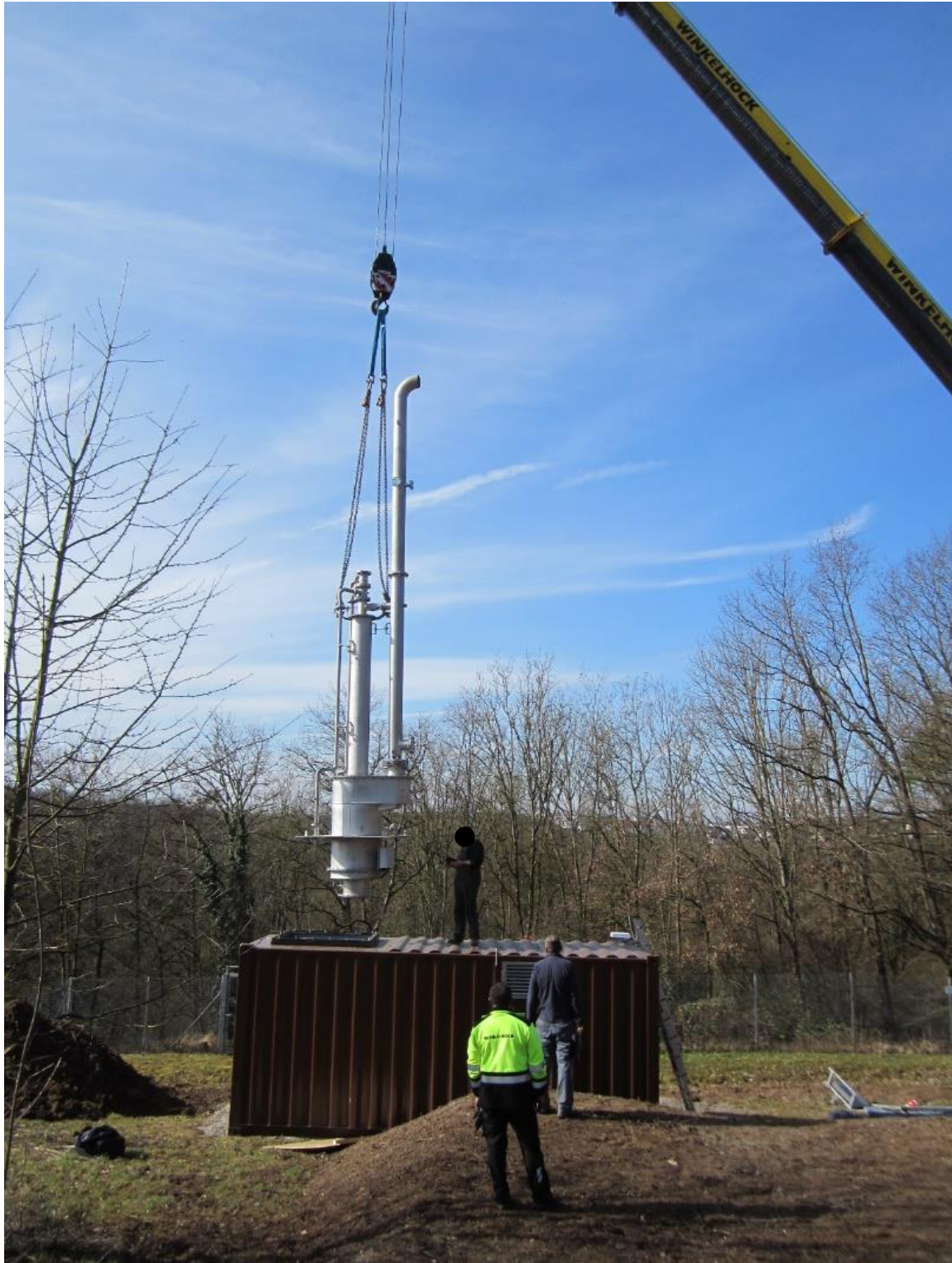
Absetzen des Kamins in den Anlagencontainer zur Montage vor Ort
