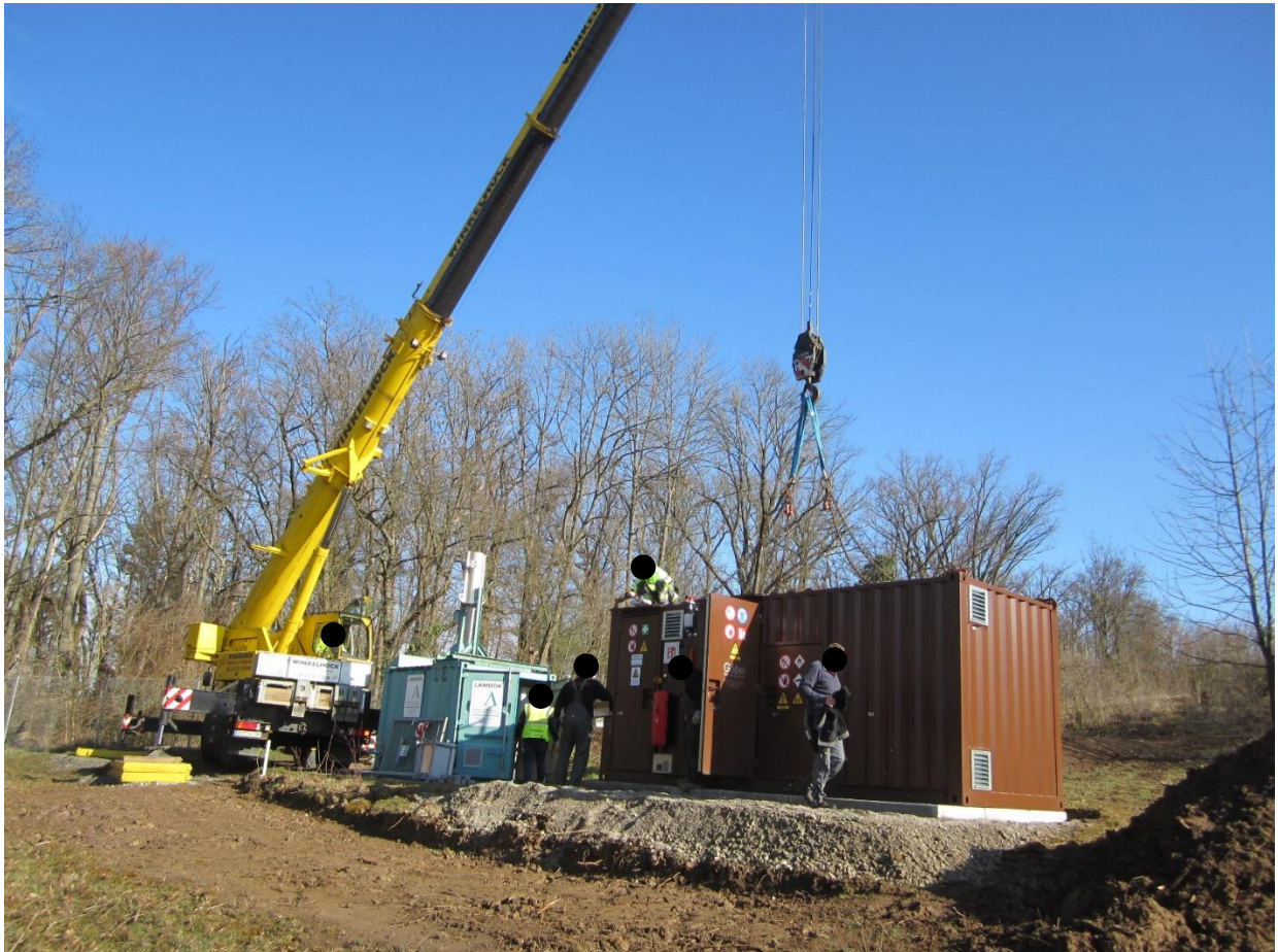
Aufstellen des Anlagencontainers mittels Autokran
