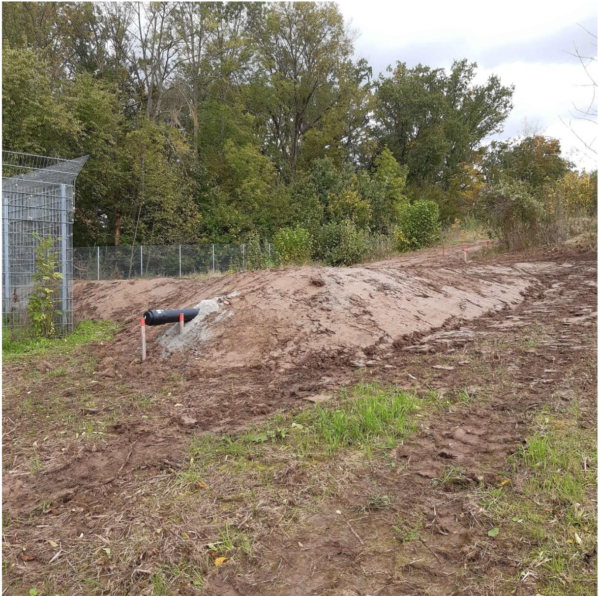
Anschlussbereite Transportleitung für neue Schwachgasbehandlungsanlage
