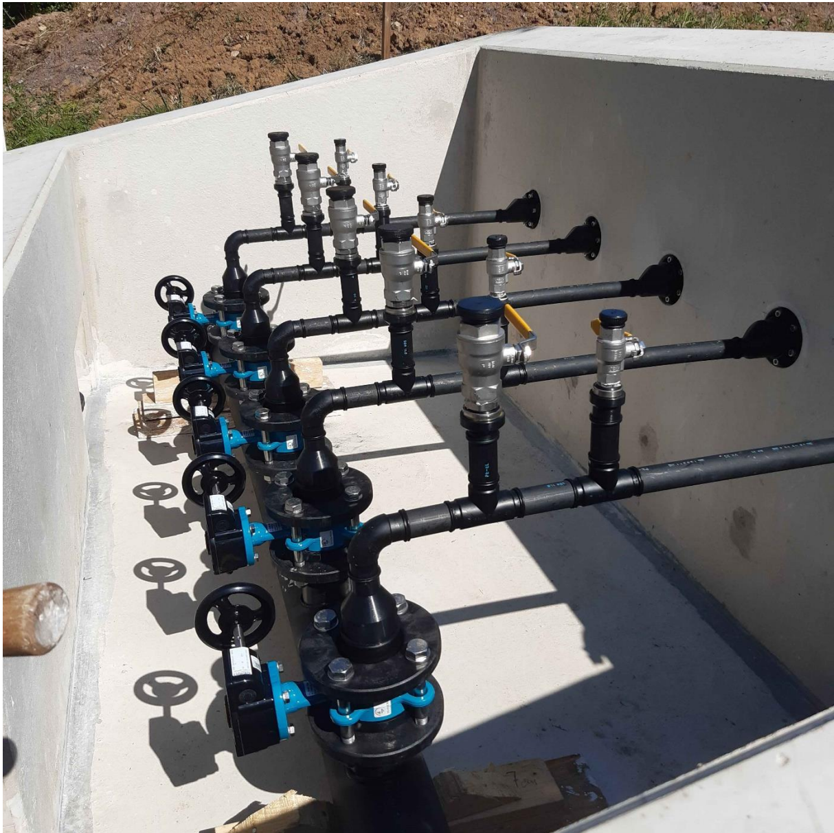
Aufbau der Gasmessstrecke in der Gasregelstation
