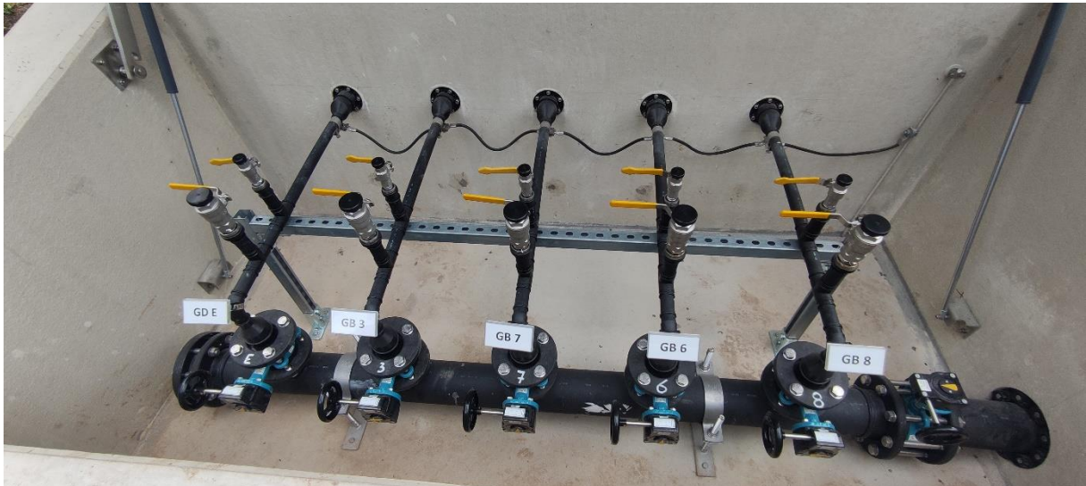
Gasregelstation mit geöffnetem Deckel, Ansicht von oben
