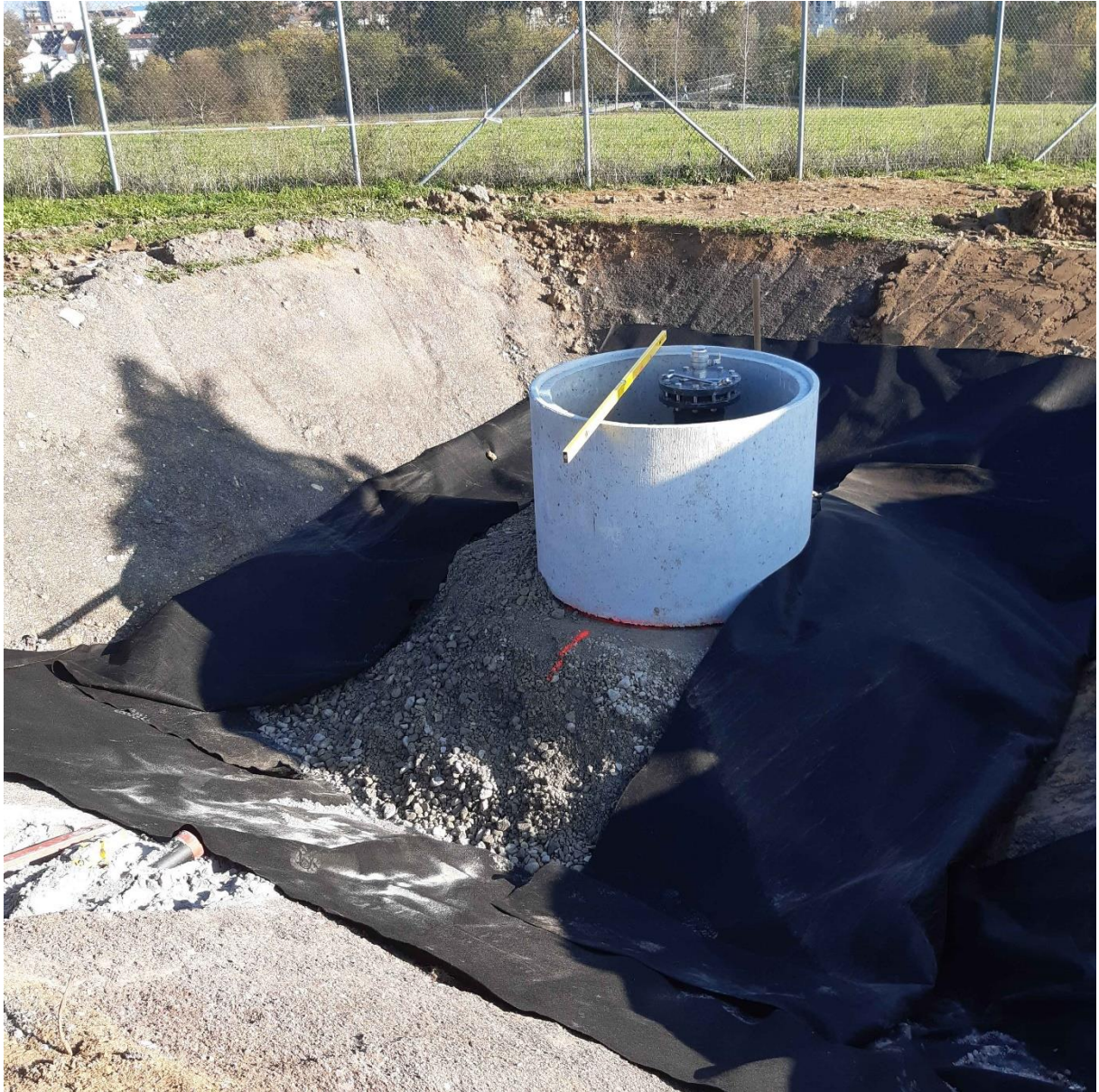
Stellen des ersten Betonschachtrings um den Brunnenkopf zur weiteren Verfüllung
