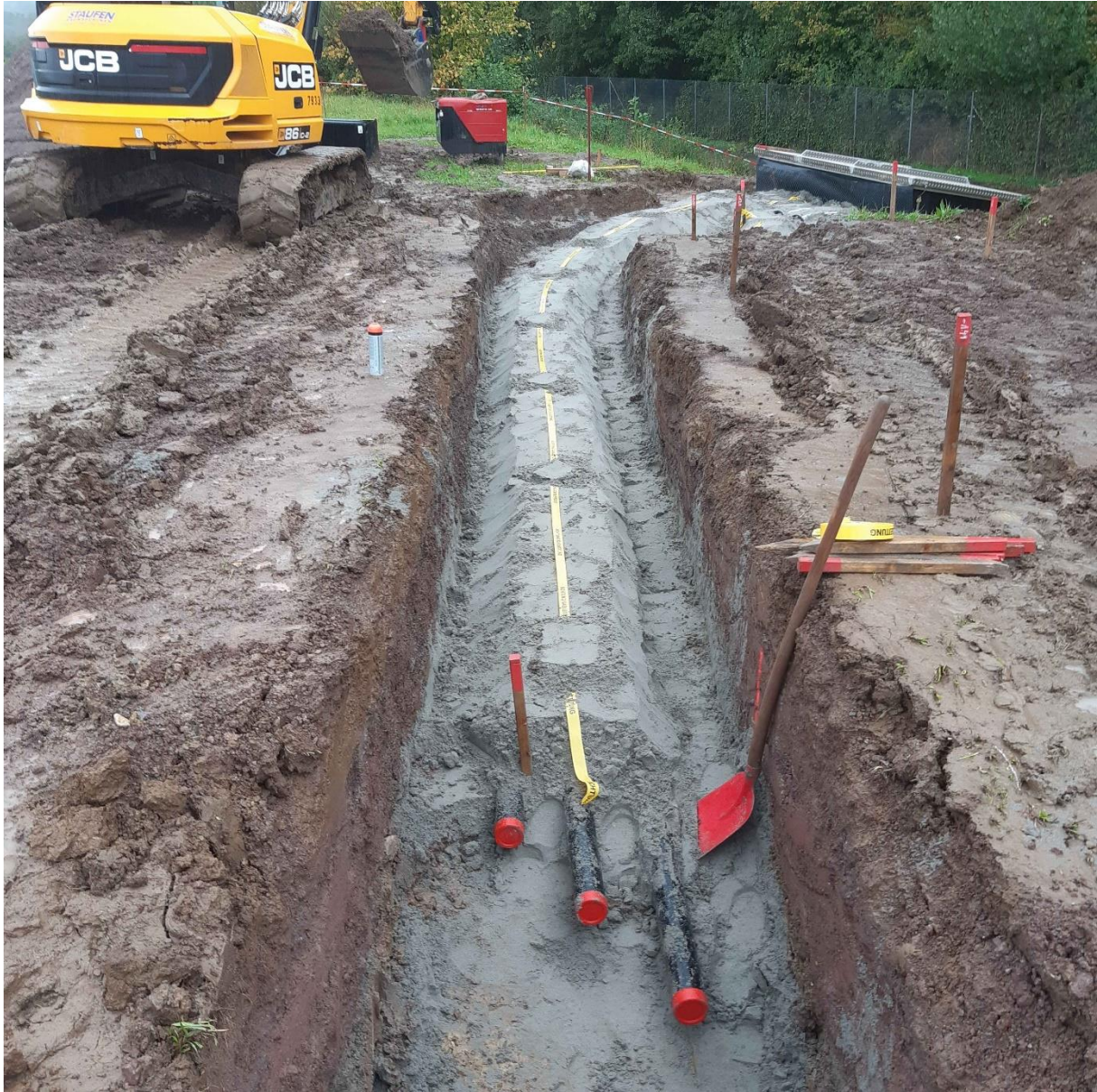
Wiederverfüllen des Rohrgrabens mit Sandschutzschicht und Trassenwarnband
