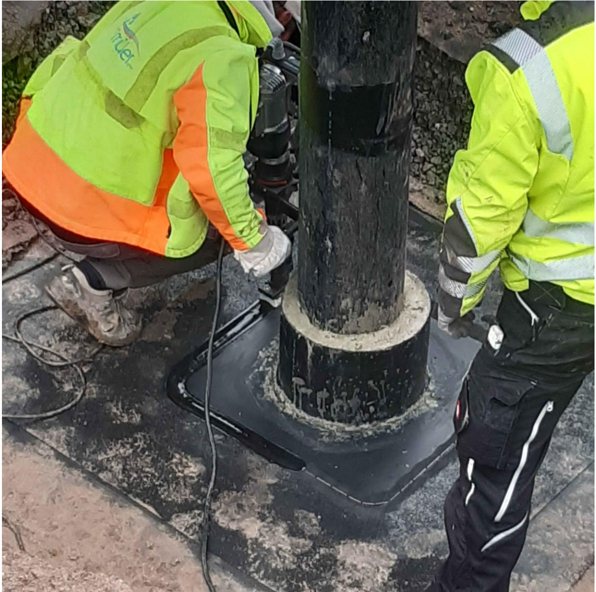
Arbeiten zur fachgerechten Abdichtung der Durchdringungen im Zuge der Brunnenbohrungen
