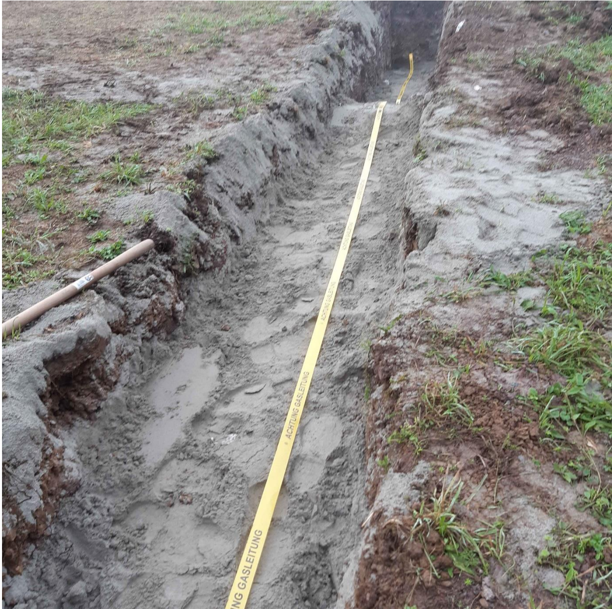
Wiederverfüllen des Rohrgrabens mit Sandschutzschicht und Trassenwarnband
