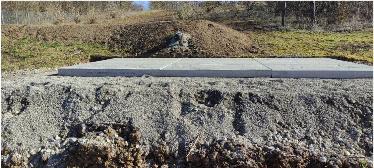
Vorbereiten der Standfläche für die neue Schwachgasbehandlungsanlage
