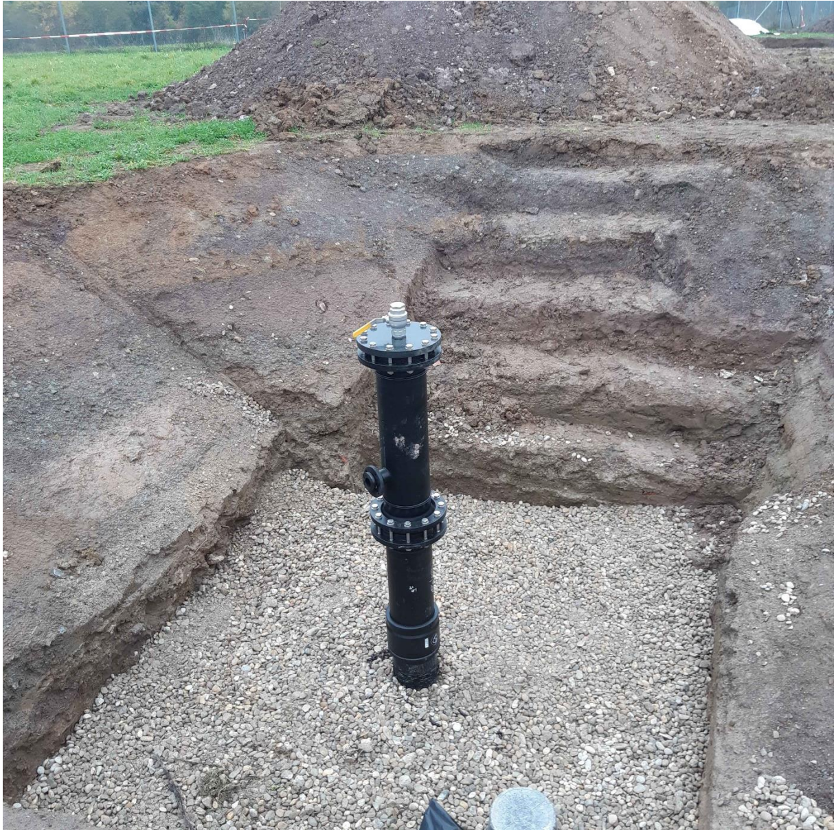
Vorbereitende Arbeiten zur Stellung der Betonschachtringe um den Brunnenkopf
