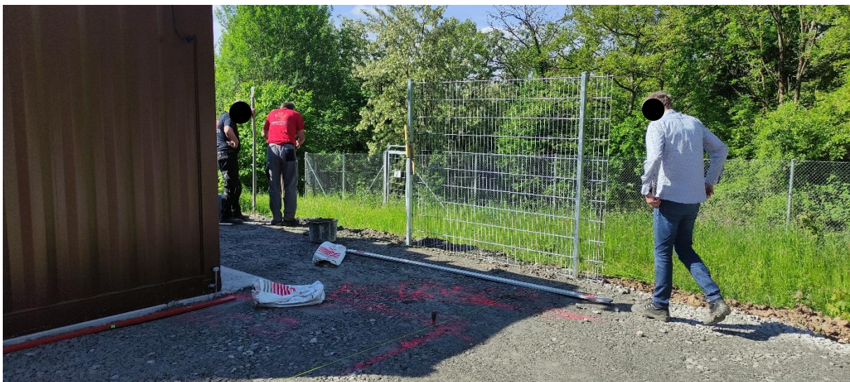
Beginn der Zaunmontage um die Schwachgasbehandlungsanlage
