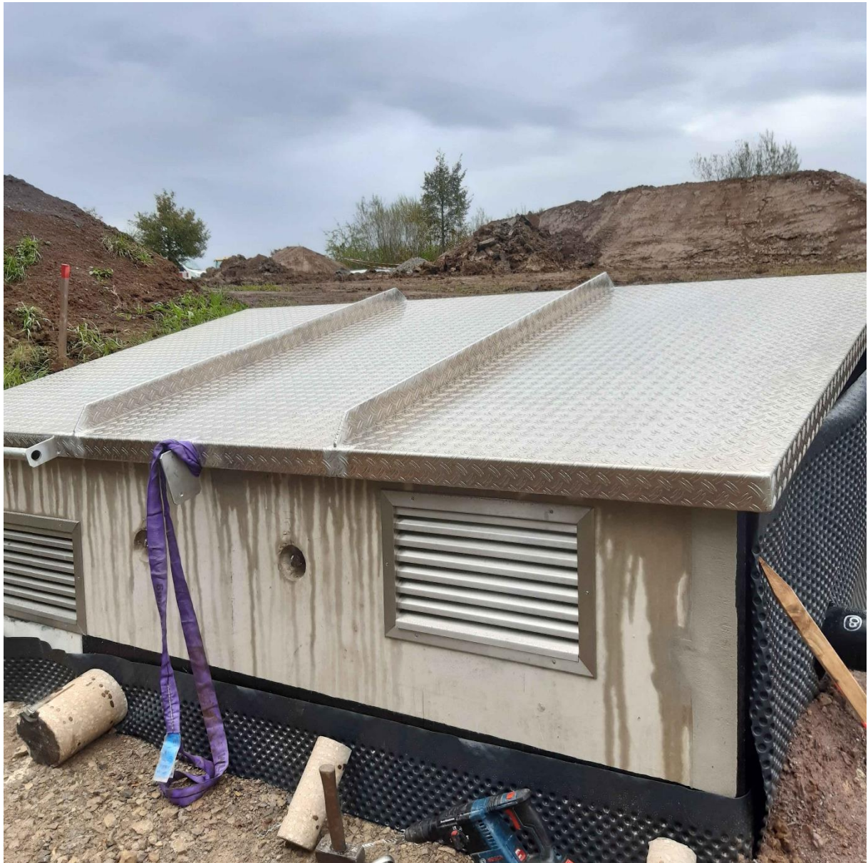
Anlieferung und Montage des Deckels
