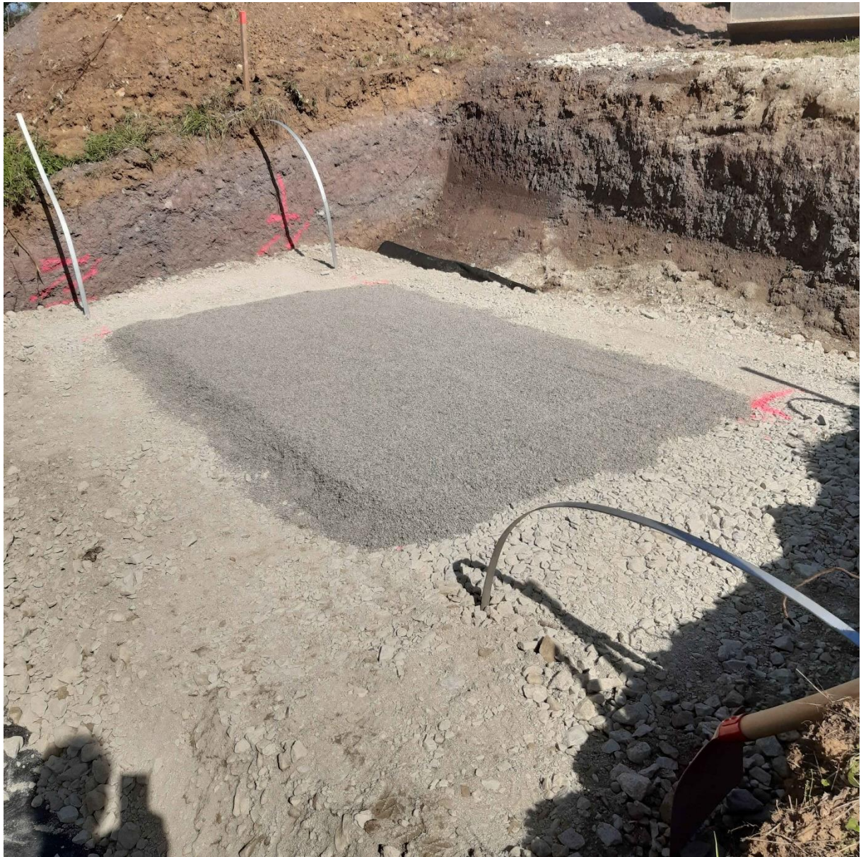
Verdichten der Aufstellfläche vor Anlieferung
