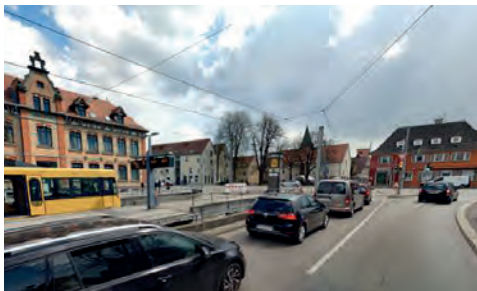
Bürgerhaus am Ortseingang Hedelfingen
