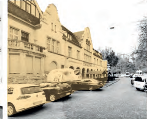
Schweinemuseum im historischen Gebäude in der Schlachthofstraße
