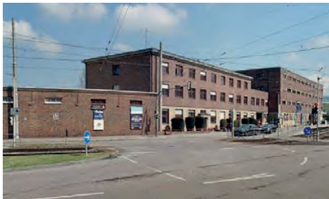
Denkmalgeschütztes Gebäude an Inselstraße
