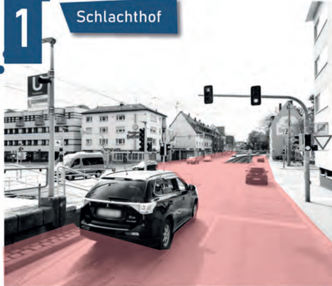
Eingang zur Tallängsachse: Haltestelle Schlachthof an der Kreuzung Talstraße / Ulmer Straße
