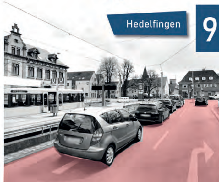
Einfahrt nach Hedelfingen mit Endstation der U9
