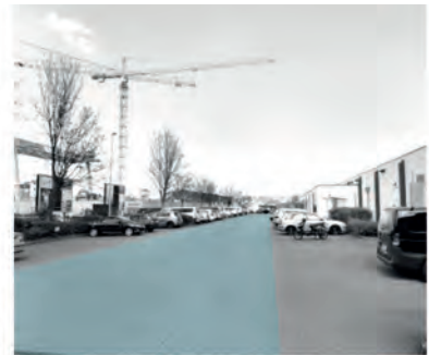
Querung des Areals Viehwasen / Inselstraße
