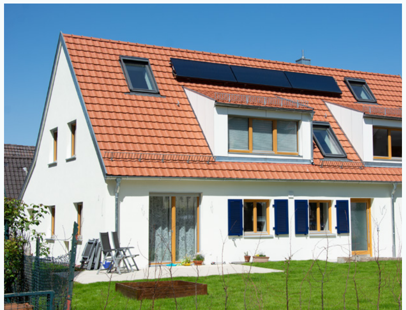
Wohnhaus in Hedelfingen vor und nach der energetischen Sanierung. Der Endenergiebedarf konnte um 63 % reduziert werden.
