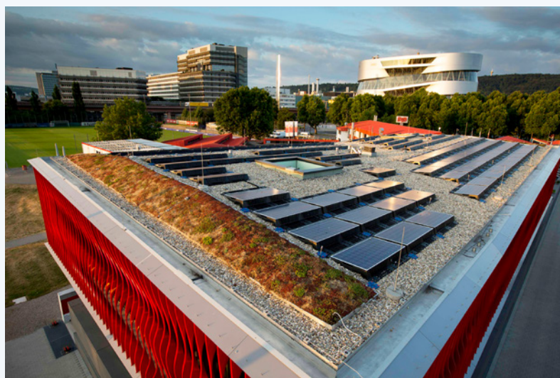
Solaranlage des VfB-Nachwuchsleistungszentrums
