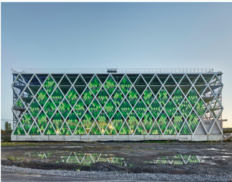
Parkhaus mit Energiezentrale zur Wärmeversorgung des Quartiers NeckarPark
