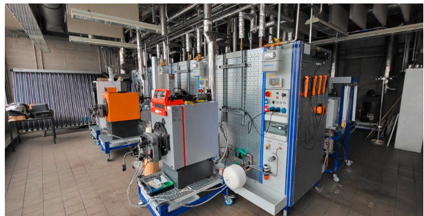
Heizungshybridraum: Links die zuschaltbaren, hybriden Heizsysteme; rechts die Wärmepumpe Foto: Frank Bader
