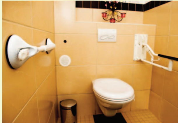
Bad (links) nach Umbau: Haltegriffe an WC und Dusche und ebenerdige Dusche
