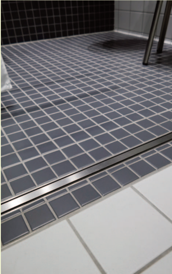
Entwässerungsrinne bodengleiche Dusche
