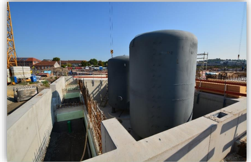
Pufferspeicher Neckarpark (6,3 und 5,5 m) (Quelle LHS)
