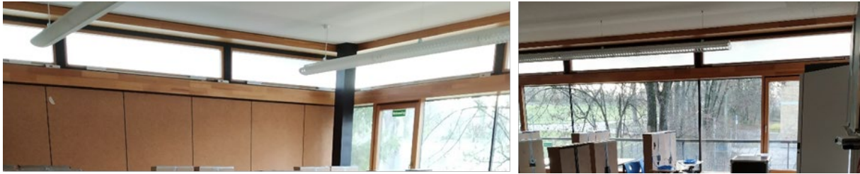
Bild 6-37: Fensterfront des Klassenraums (Uhlandschule Neubau)
