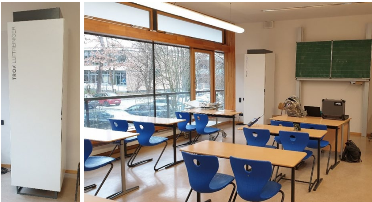
Bild 6-38: Luftreinigungsgerät und Aufstellort im Klassenraum der Uhlandschule Neubau
