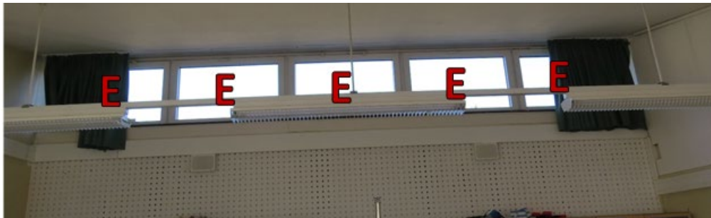
Bild 6-27: Fenstertypen in der Steigschule Bau 1, kleine Fensterfront
