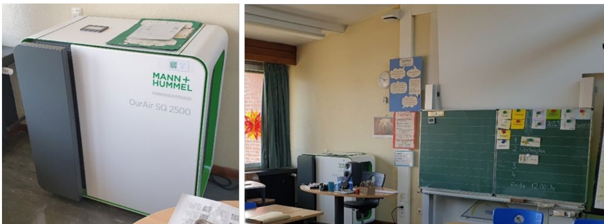
Bild 6-25: Luftreinigungsgerät und Aufstellort im Klassenraum der Steigschule Bau 1
