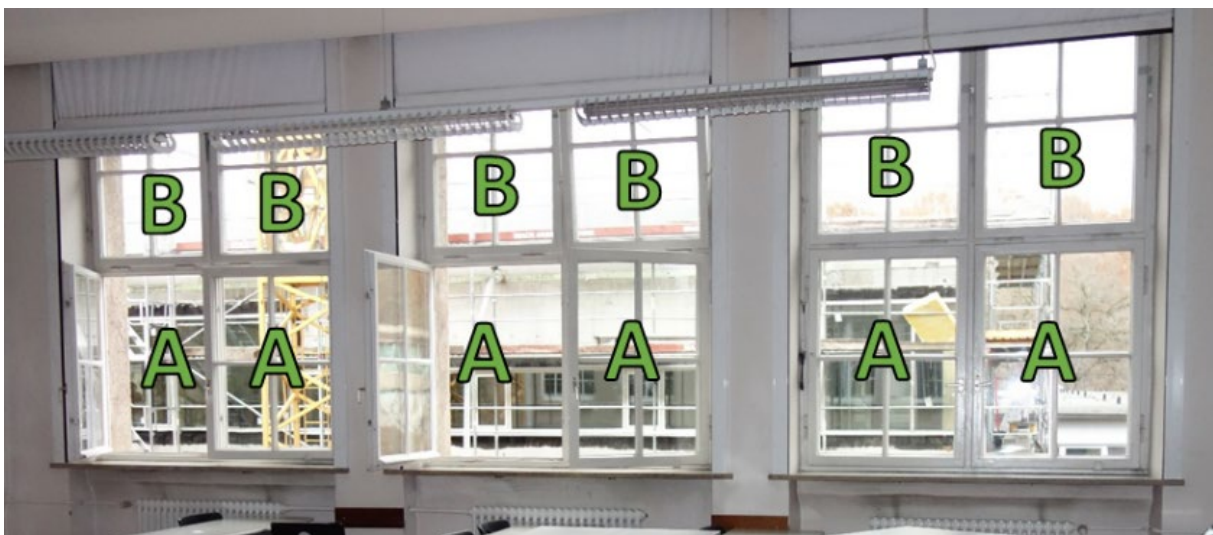
Bild 6-47: Fenstertypen im Referenzraum, Zeppelin Gymnasium
