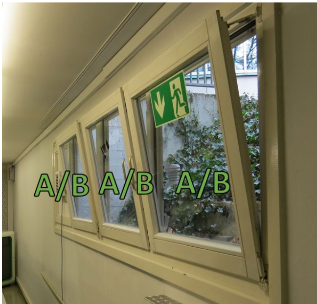
Bild 6-33: Fenstertypen in der Steinbeisschule Hauptbau
