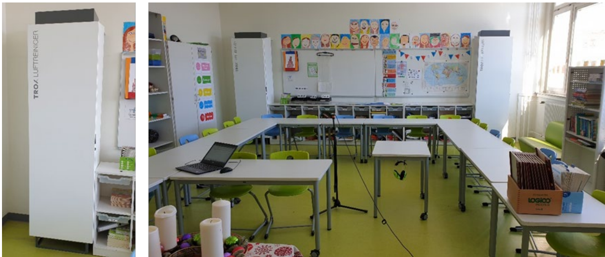
Bild 6-14: Luftreinigungsgerät und Aufstellort in der Schwabschule
