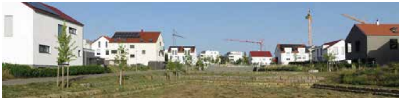
Baufortschritt (Juni 2022) im Neubaugebiet Langenäcker-Wiesert im Stadtbezirk Stammheim (Foto: Lutz Deutz)
