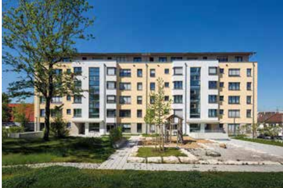
Neubau von 34 Mietwohnungen in der Fürfelder Straße im Stadtteil Rot, davon 17 Sozialwohnungen, Bezug 2018 (Foto: SWSG)
