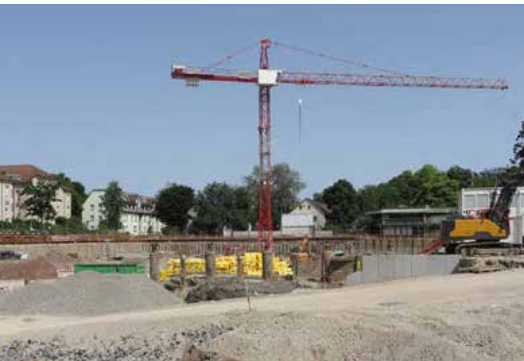
Baustelle in der Künzelsauer Straße im Stadtbezirk Zuffenhausen nach Ende der Altlastensanierung in der ehemaligen Keltersiedlung im Juni 2022 (Foto: Lutz Deutz)
